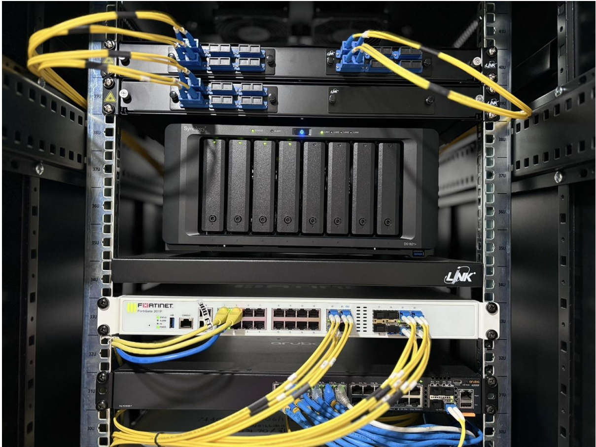
รูปภาพที่ 12 Network attached storage (NAS) สำหรับสำรองข้อมูล
